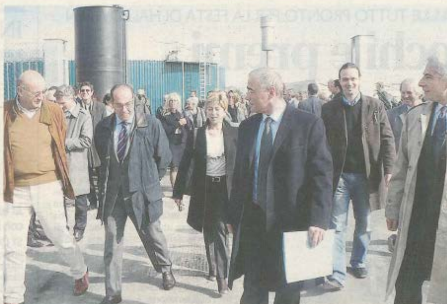
La centrale di Bondeno è il più grande parco energetico a biogas da biomassa agricola in Italia
